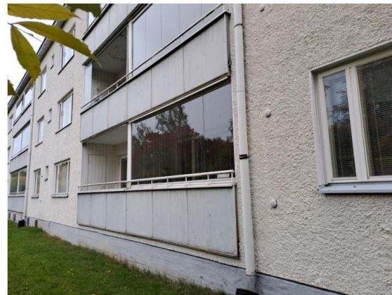
Kuva 3. Vuonna 1959 rakennettu asuinkerrostalo Sipoossa. Kaiderunko tehty hitsattuna L-teräksistä ja kaide verhoiltu kuitusementtilevyillä (Kuva: Teemu Lensu).
