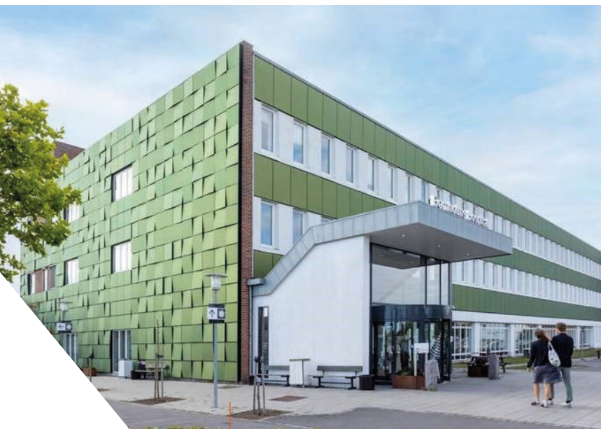
Aurinkosähköjulkisivu Kuva: Solarlab
